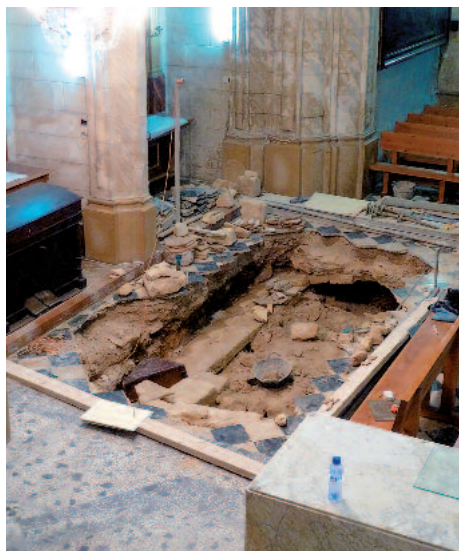
Detall de les obres del Roser en el Convent
